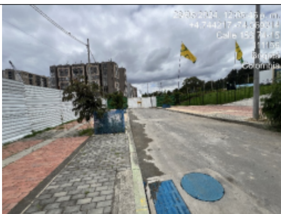
Fotografía 8. Material de arrastre directamente a sumidero. Visita del 28 de mayo de 2024.
