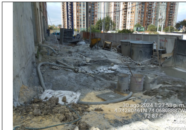
Fotografía 5. Mezcla y lavado de motobomba directamente en suelo. Visita del 30 de agosto de 2024.
